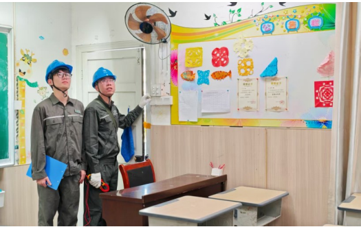
检查教室用电设备。
