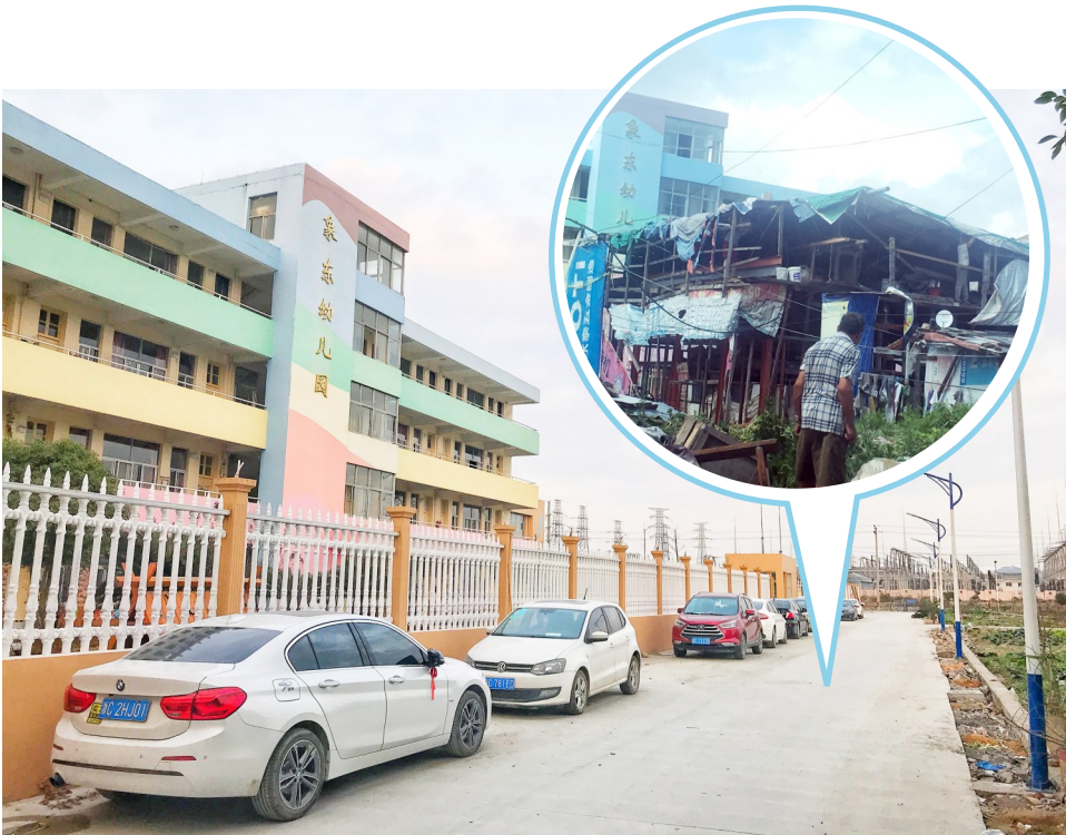
象东幼儿园园前拆后新建了水泥路。
