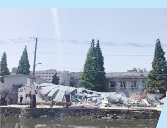
违章厂房被拆除。
