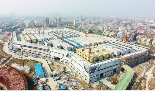
建设中的电工电器城。
