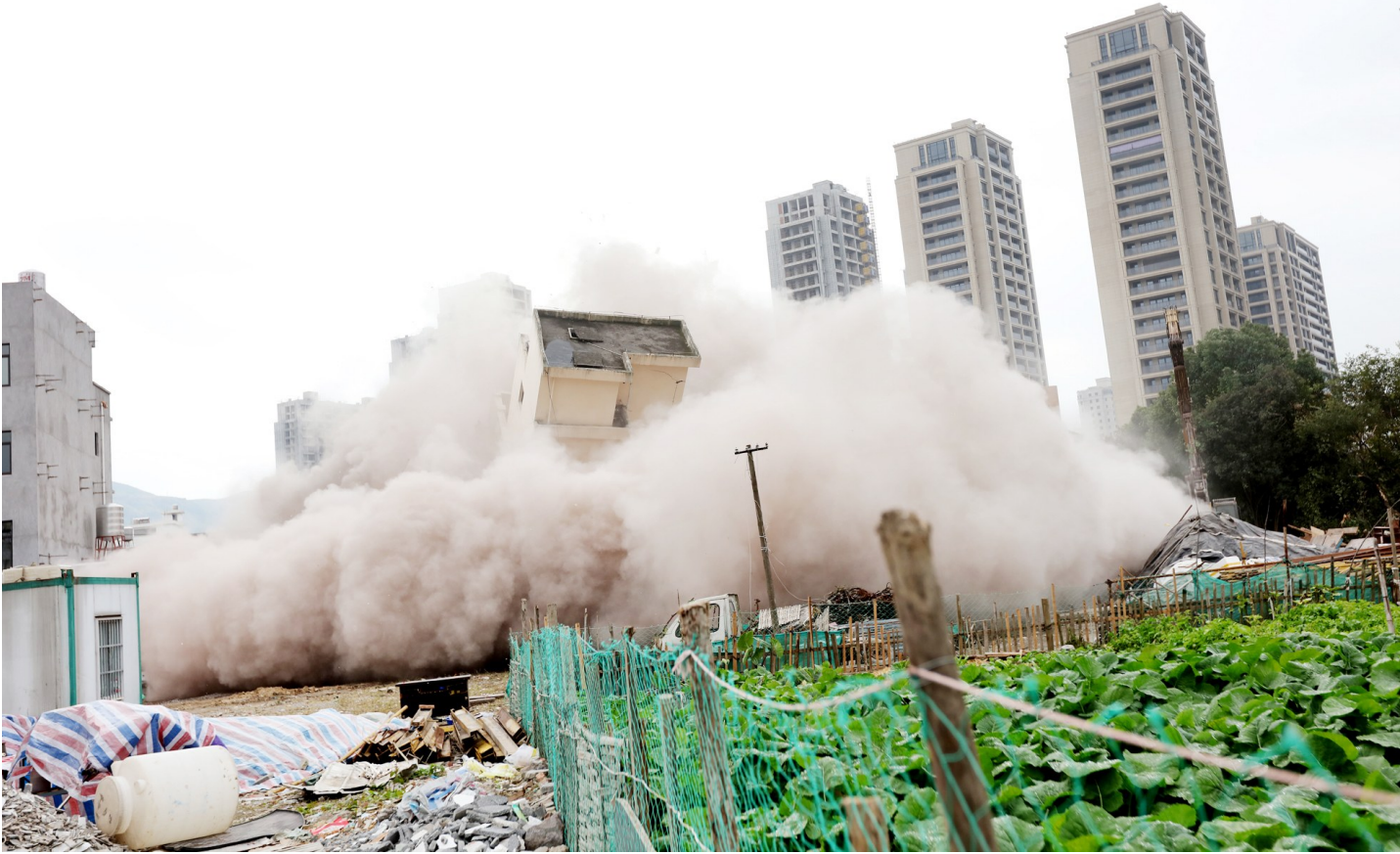
南草垟村 第一高楼 拆迁现场。记者 刘言勇 摄
