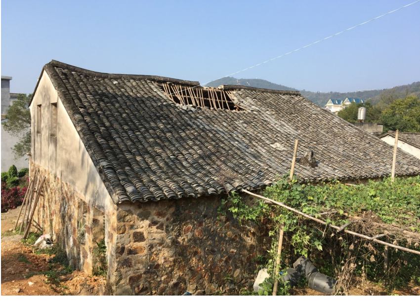
大乌石村拆除危旧房。
