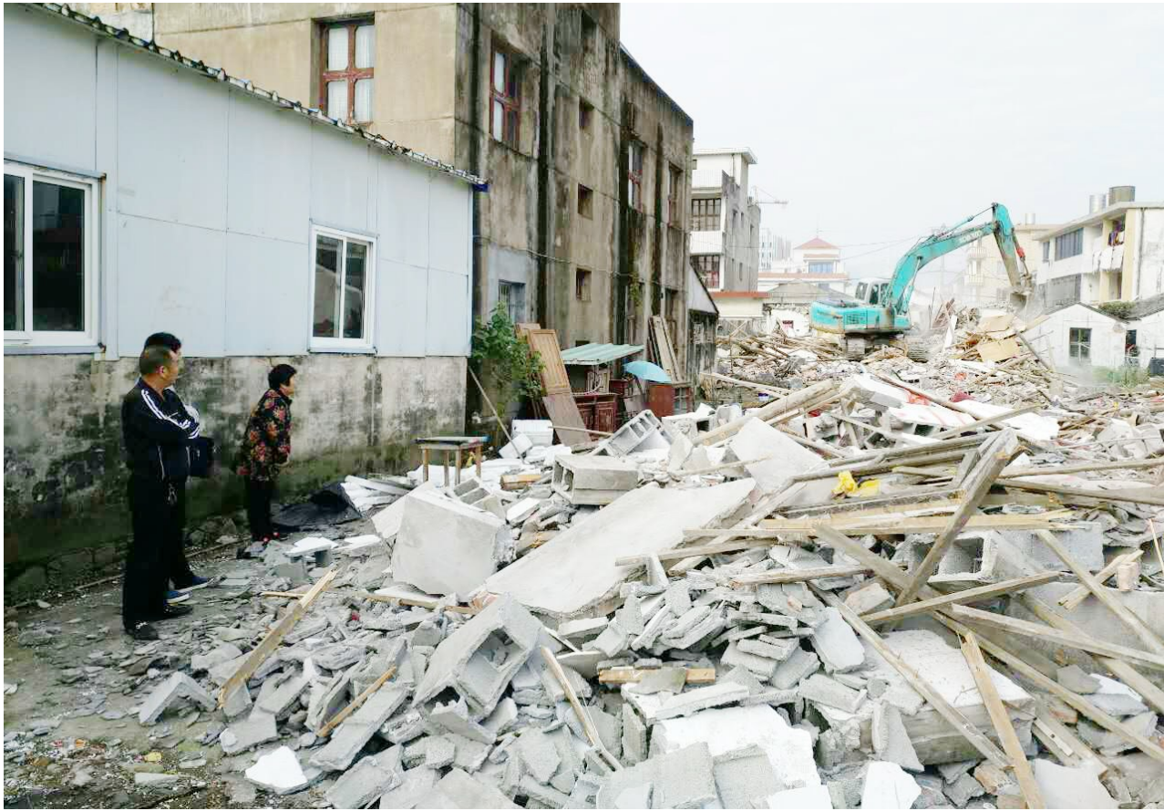
晨曦路延伸工程第一拆。程遥 摄
