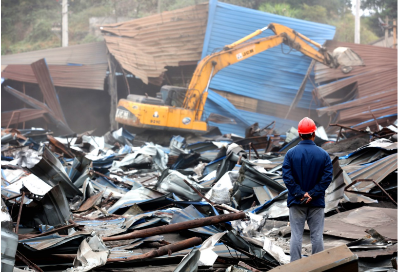
11月29日，大荆横山头工业区，拆迁工人在现场作业。记者 刘言勇 摄
