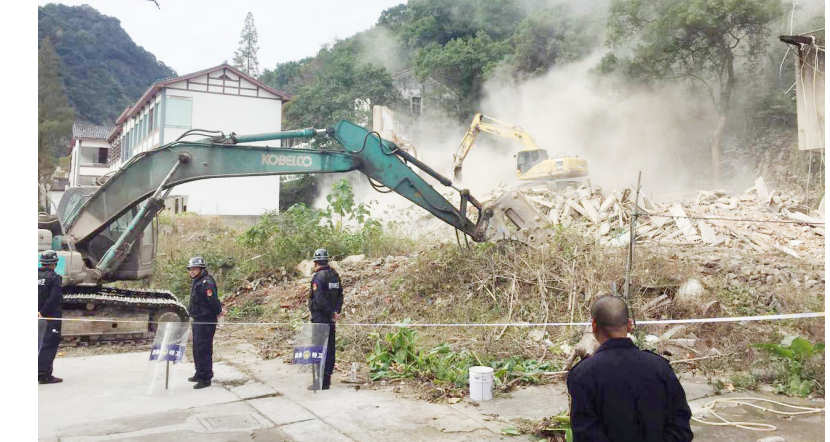
原雁荡中学老校舍被拆除。通讯员 蔡朝滨 摄
