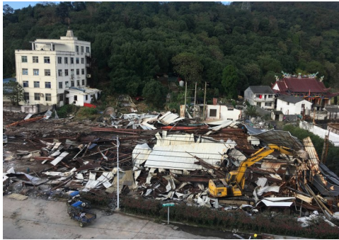
厂房被拆除后。淡溪镇供图
