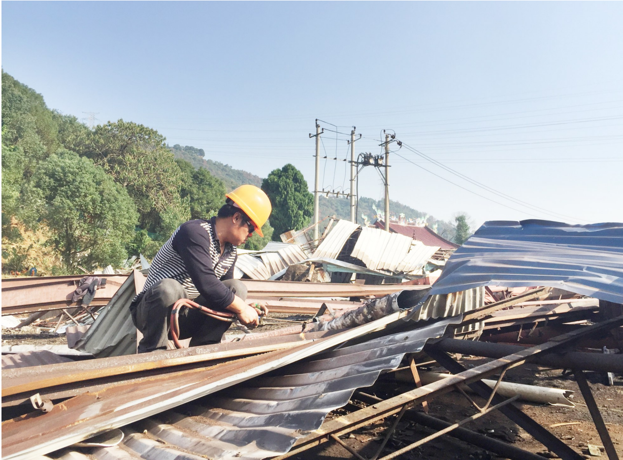
工人拆割铁棚。
