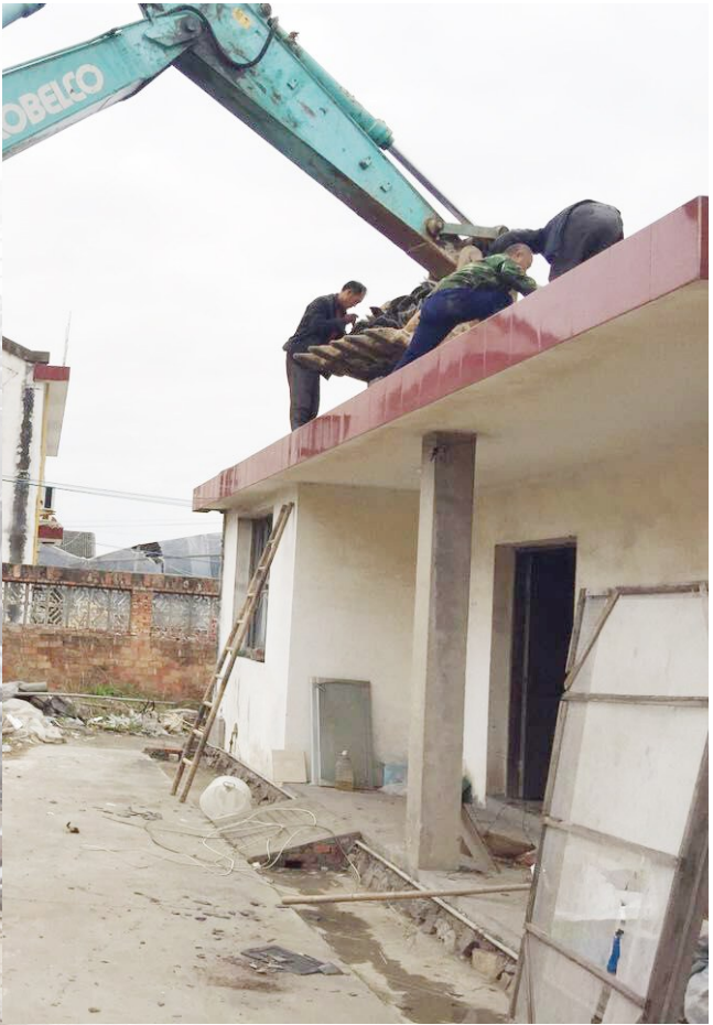
图为昨日上午拆迁现场。叶长一 摄
