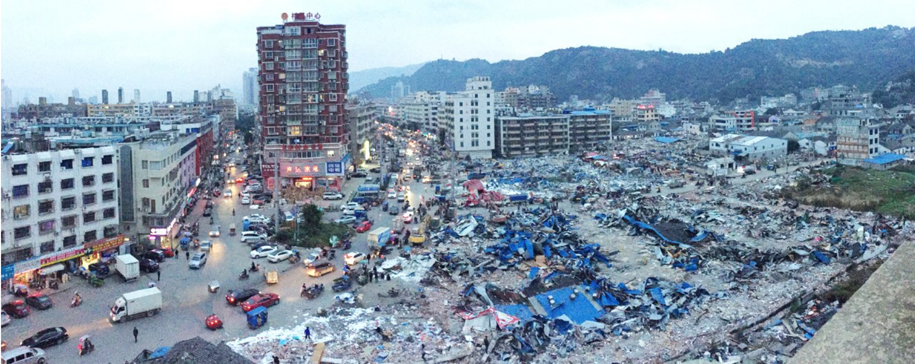
长丰老村拆除后全景。
