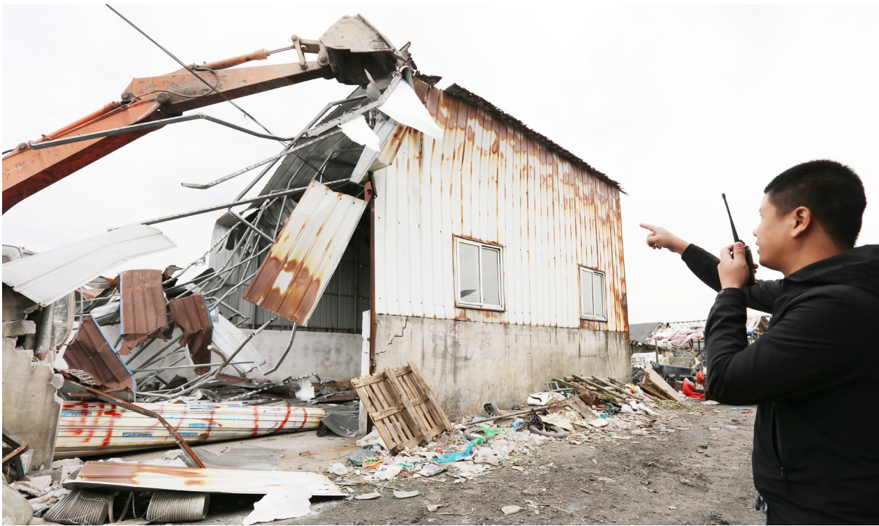
柳市镇拆违现场。记者 刘言勇 摄
