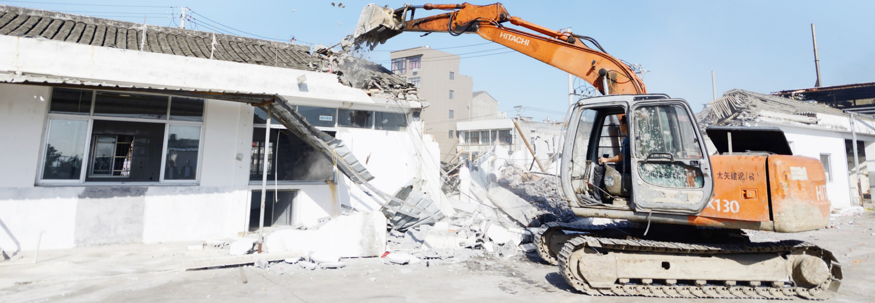
东门外村拆除违建现场。黄瀚 摄
