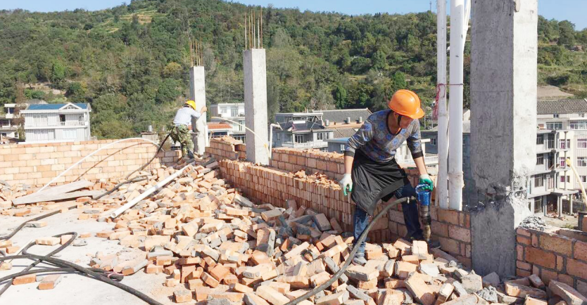
人工拆除。雁荡镇综合执法中队供图
