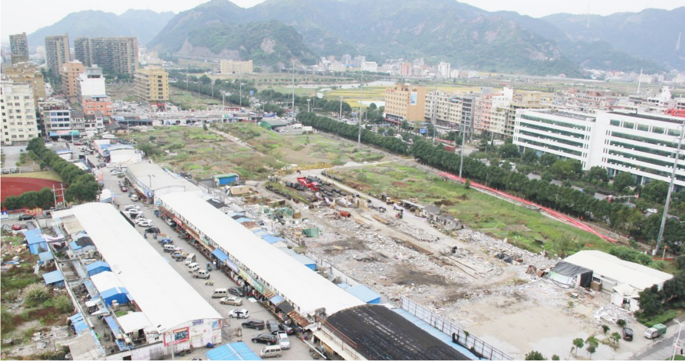
五金机电市场第一期建筑面积为1.1万平方米的多家违建厂房已于11月4日集中拆除，第二期2万平方米违建店铺群于昨日全部拆除。
