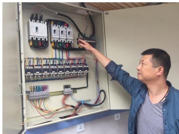
包建平展示漏电保护开关。
