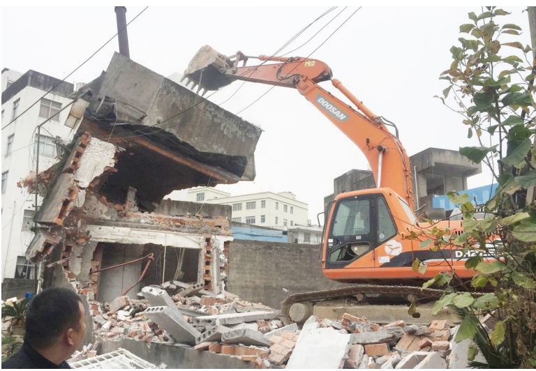
11月9日,湖雾镇主要负责人率全体机关干部,再次对湖雾工业区进行拆违,当天共拆除违建12000余平方米。记者 张孟涛 摄
