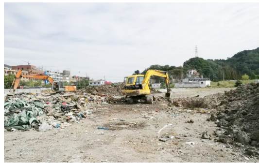
挖掘机拆除违章建筑。
