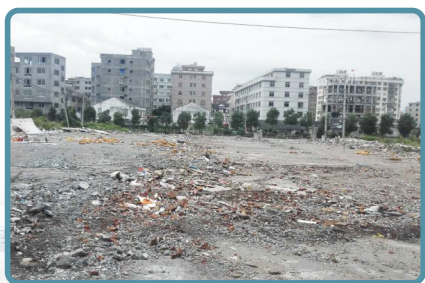
宝丽来 违建厂房拆除前。
