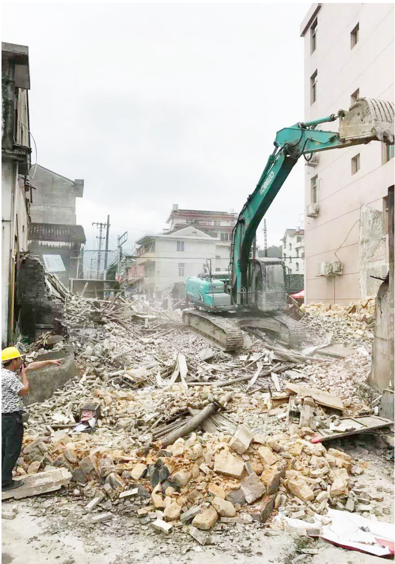
长山头村拆除危旧房现场。通讯员 臧剑锋 摄
