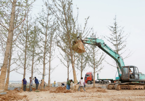
近段时间,乐清经济开发区对园区重要路段绿化节点进行改造提升,图为建设场景。卓礼丰 摄
