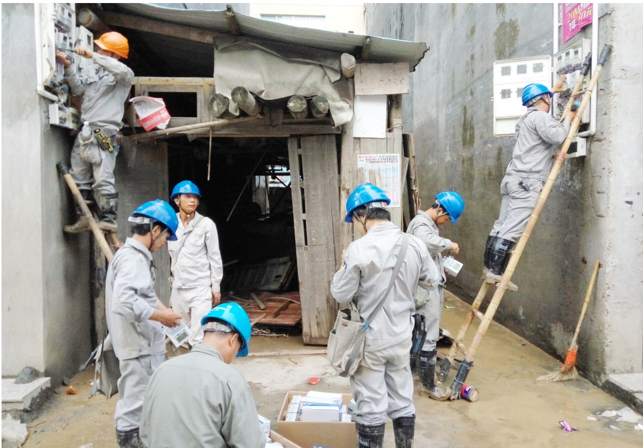
抢修人员正在安装电表。通讯员 徐玉 摄
