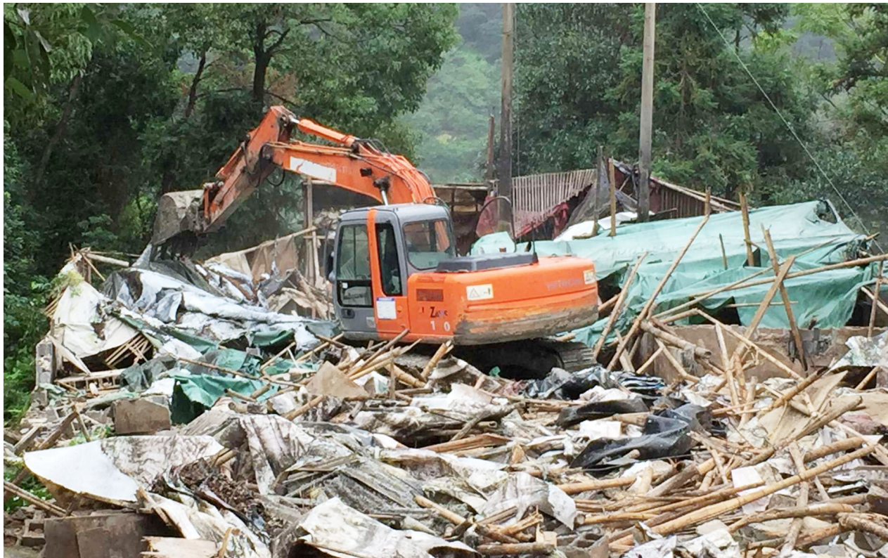
拆除养猪场。蔡甜甜 摄
