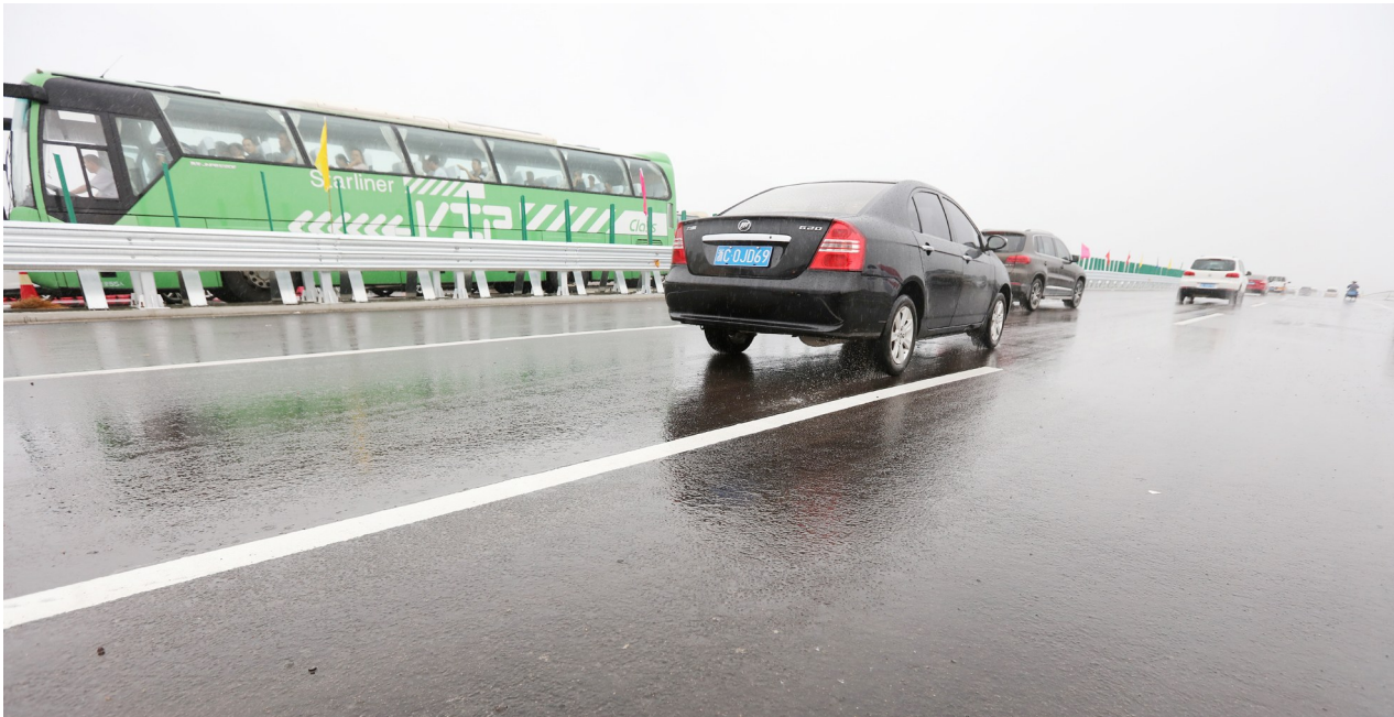
车辆行驶在刚刚贯通的疏港公路上。记者 刘言勇 摄
