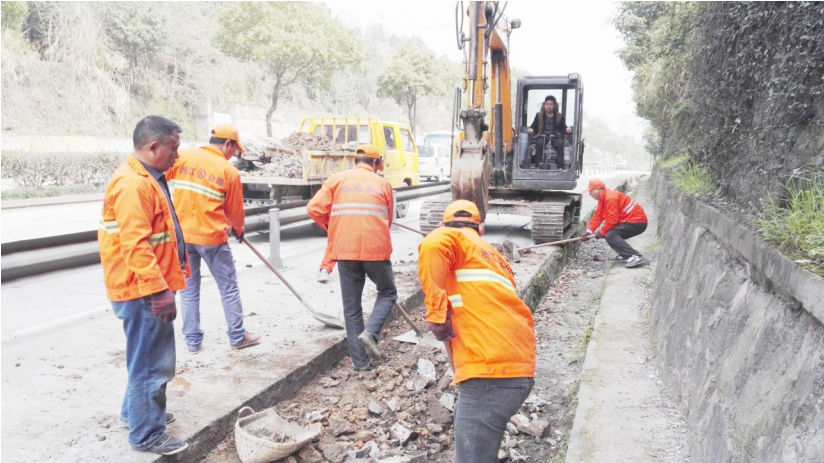
施工人员现场忙碌。记者 杨海虹 摄
