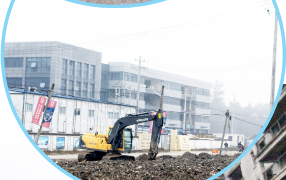
新市三医旁长江路延伸段正在施工。
