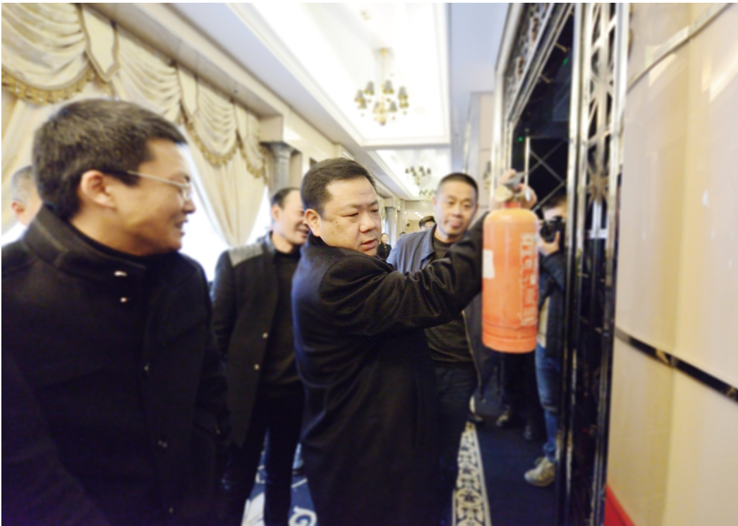
潘云夫检查娱乐场所消防设施。黄瀚 摄
