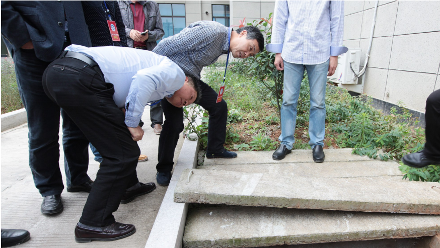
督察员俯身察看污水处理池
