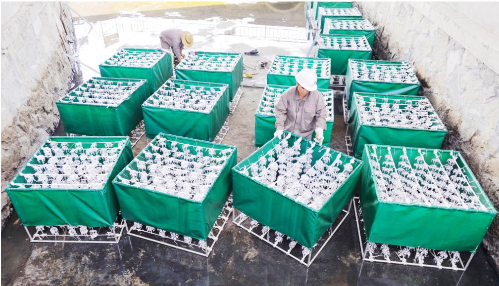
荷岙村污水处理池施工一景。
