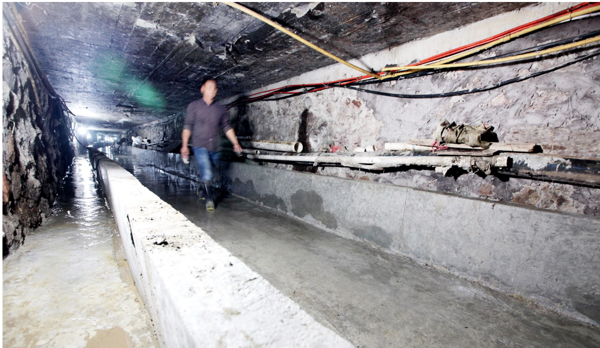
雨污分流工程中的封闭式河渠。 记者 刘言勇 摄
