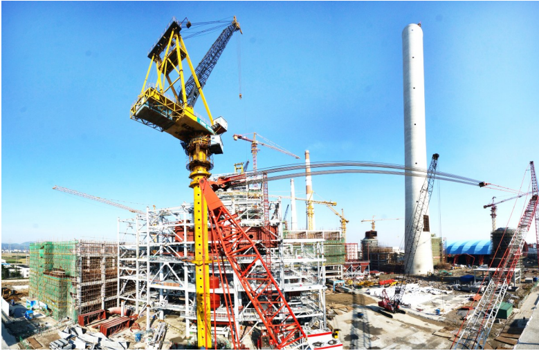
四期工程全景图。通讯员 张勇 摄
