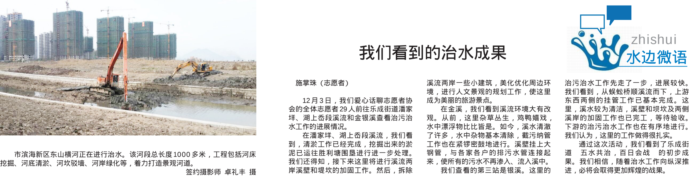
市滨海新区东山横河正在进行治水。该河段总长度1000多米，工程包括河床挖掘、河底清淤、河坎驳墙、河岸绿化等，着力打造景观河道。 签约摄影师 卓礼丰 摄
