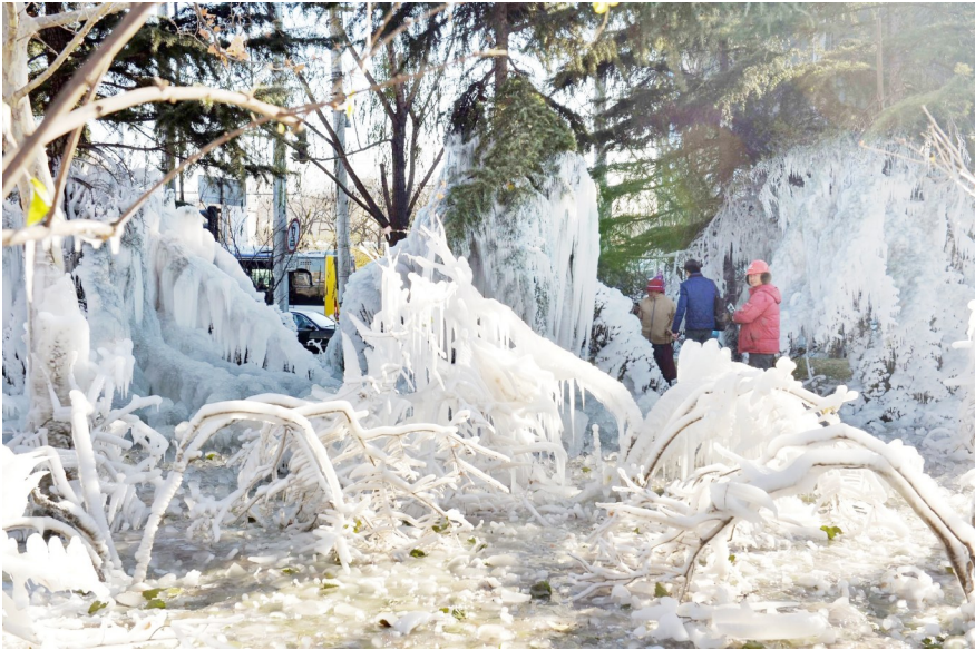
12月1日凌晨，北京天桥艺术大厦旁绿化带内一水管发生爆裂，致使大量水流喷涌而出。由于气温较低，数小时后绿地内形成了近300平米的冰挂景观。据介绍，当天北京南郊观象台的最低气温为-5.4℃，是今年入冬以来最低。据北京晚报
