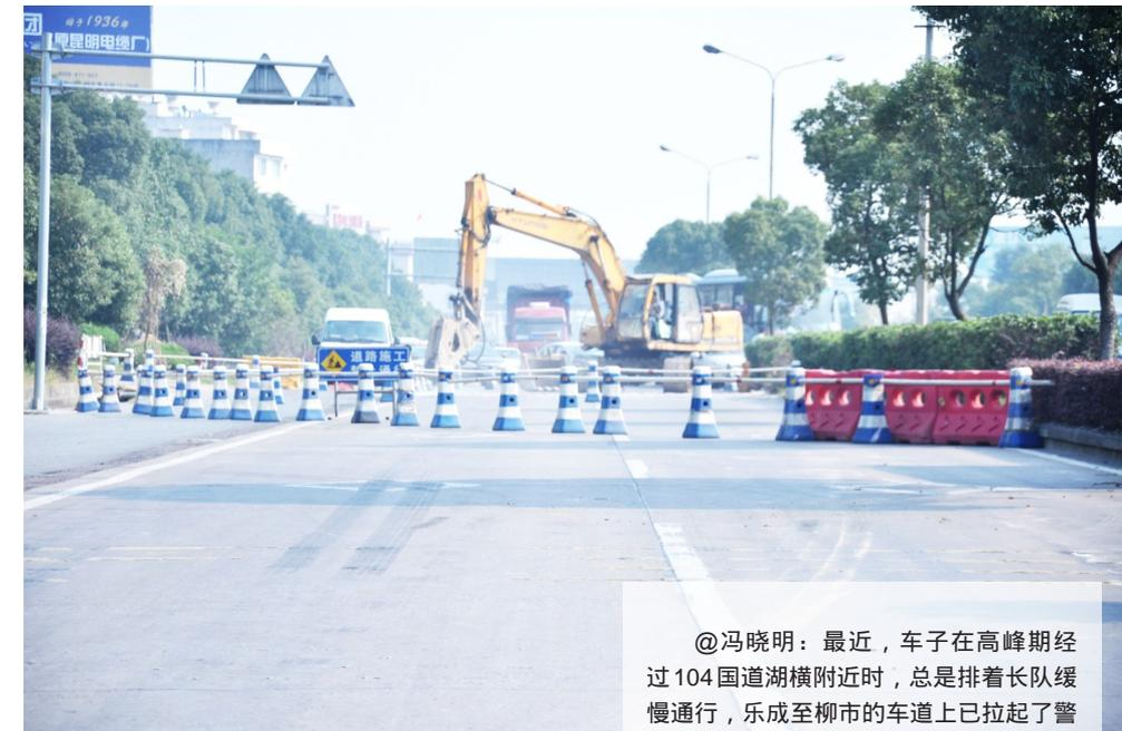
@冯晓明：最近，车子在高峰期经过104国道湖横附近时，总是排着长队缓慢通行，乐成至柳市的车道上已拉起了警示标志，车子被引流到另一侧的道路上。乐清市公路管理局的工作人员说，这一带地势低，每到雨季，经常遭遇山体滑坡，污泥容易堵住下水道，以致水淹路面，给市民出行带来不便，附近村民反应强烈，最近施工队正在增设路下涵洞，以解决这一难题。
