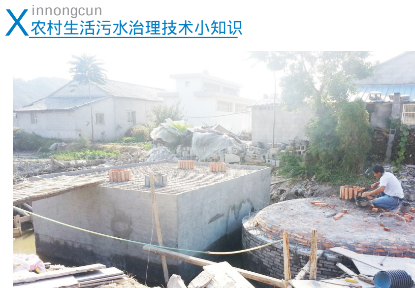
生活污水处理池施工。(市农办供图)
