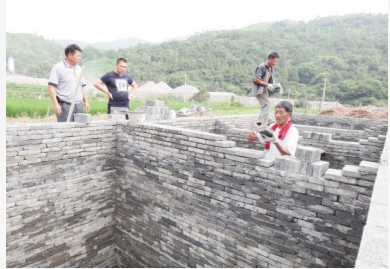
贮液池施工。杨云峰 摄
