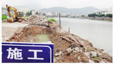
河岸施工。杨云峰 摄
