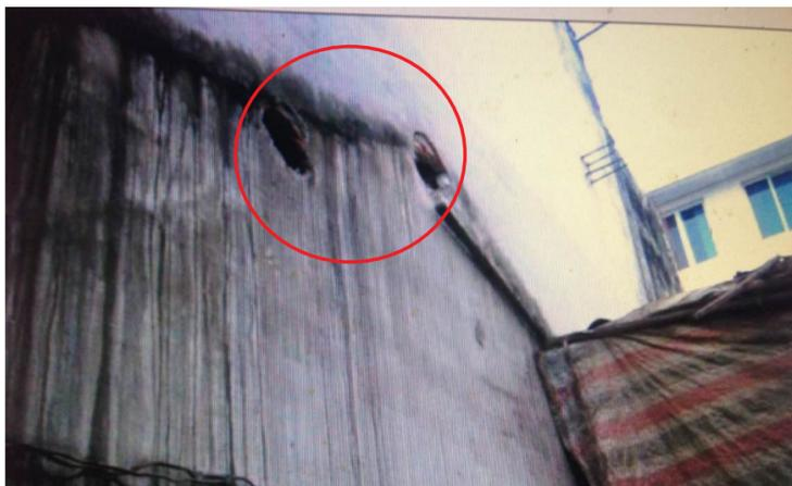
图中红圈处:主梁断裂掉落,屋外留出两个洞。侯婷婷 摄
