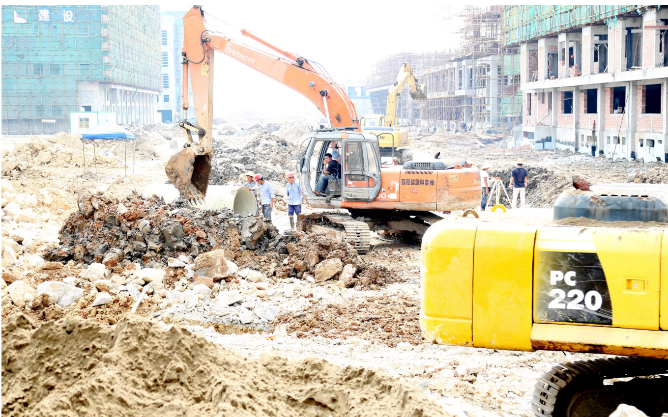
日前, 乐清经济开发区环保产业园加快跟进园区配套工程, 投资7000万元用于道路建设, 4条主干道总长度约2500米, 已完成招标, 其中纬十九路已开工建设。图为管网铺设及回填现场。 签约摄影师 卓礼丰 摄
