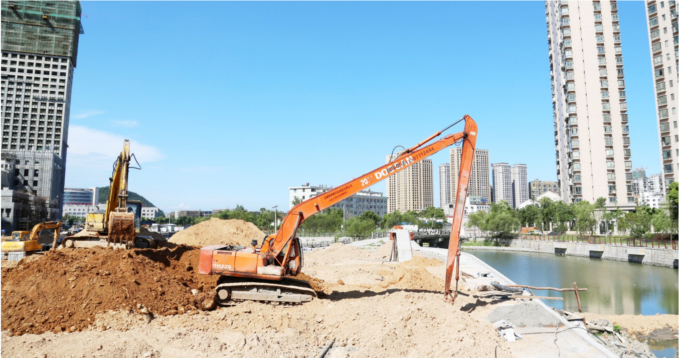
南虹广场即将竣工，近日商贸城北岸绿带开始启动建设。乐成中心城区管委会有关负责人介绍，商贸城南北岸绿带是乐成中心城区4公里长的绿化轴的重要组成部分，目前商贸城南岸绿带工程已完工，北岸绿带工程将于年内完成。图为商贸城北岸绿带工程施工现场。
