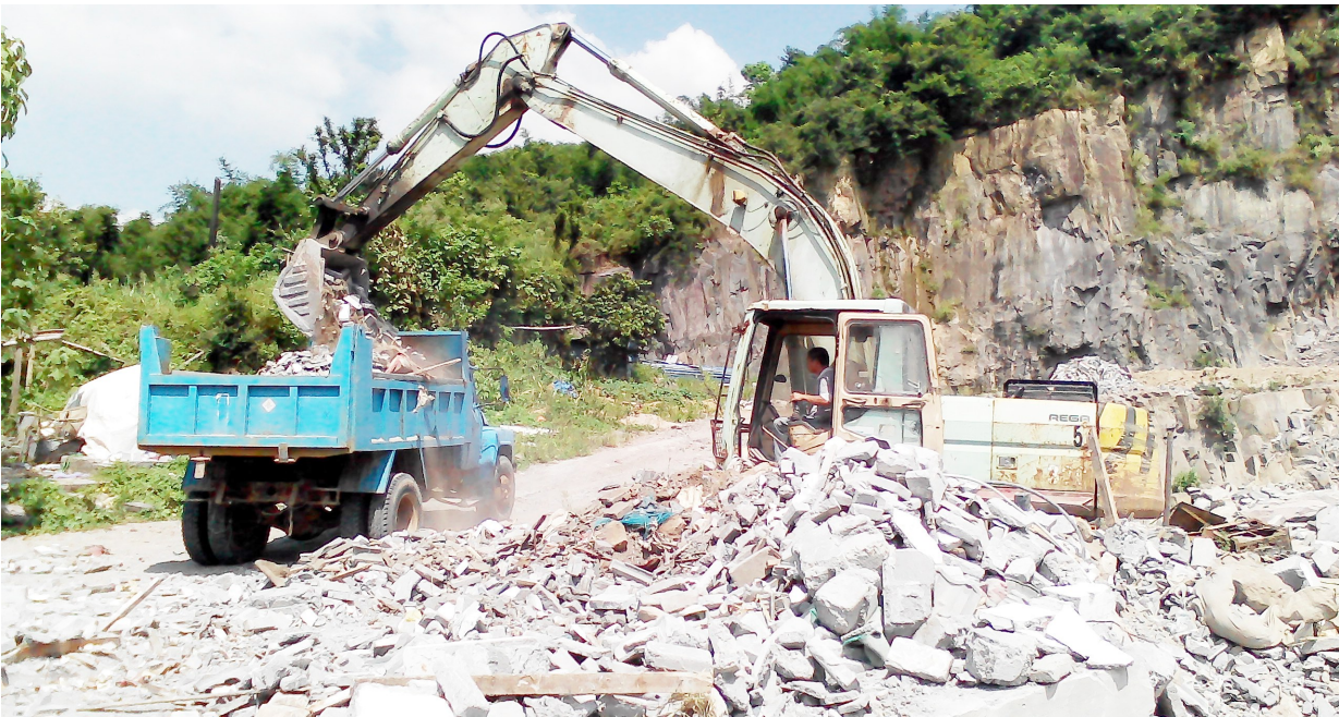
拆后垃圾清运。杨云峰 摄
