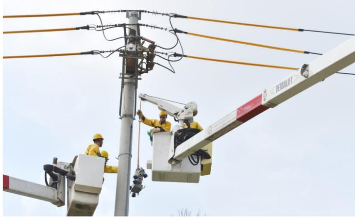
近期, 我市用电高峰来临, 8月5日上午, 市供电部门在乐清经济开发区带电对110kV 盐盆变纬二204线31-01#杆进行柱上开关更换。据悉, 这是我市第一次 试水 10千伏带负荷更换柱上开关项目。
