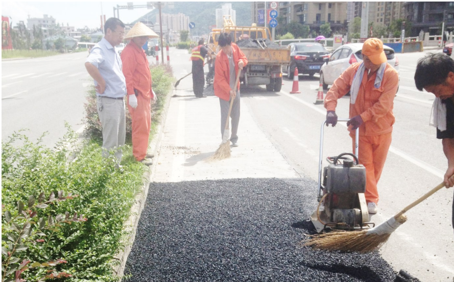
工人顶着烈日养护公路。陈蕾 摄
