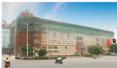
外立面施工中
