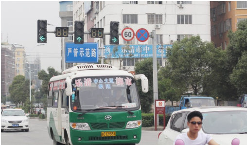
柳黄路柳市法院旁的交通信号灯失灵。
