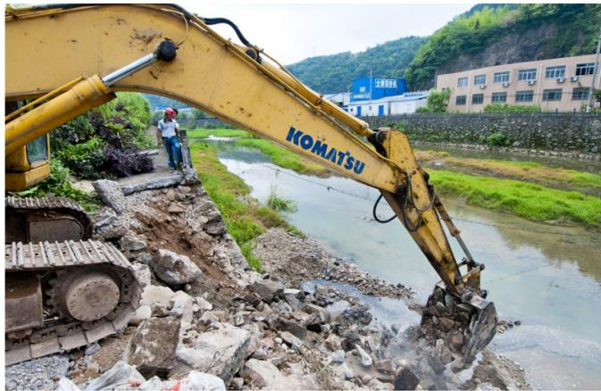
6月9日,大荆镇污水收集管网改造工程现场的工人们正在紧张施工。目前已完成一级管网建设3.6公里、二级管网建设9公里,正在铺设通往薄湾等村的三级管网。 签约摄影师 叶金涛 摄
