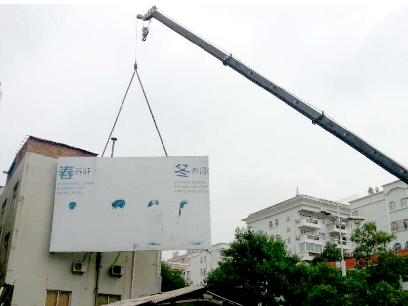
拆除现场。叶建忠 摄
