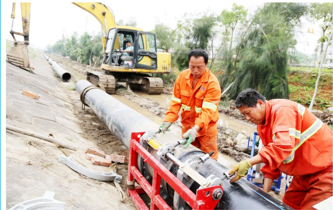
5月27日,乐清经济开发区管委会组织施工队正在紧张地铺设污水管道。该工程南起环保产业园,北连中心大道接入市污水总管,全长约1000米,设计标准为日排放量一万吨,预计6月底完工。
