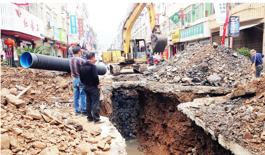
近日,雁荡镇玉溪路,几台挖掘机把路挖开,铺设管道。雁荡镇城镇生活污水管网建设全面铺开,分期分段实施污水二级管网和农村管网并入主管网,进一步扩充全镇生活污水收集的管网,以有效改善白溪水环境。签约摄影师 叶金涛 摄
