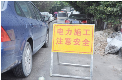
沿河西路施工现场。
