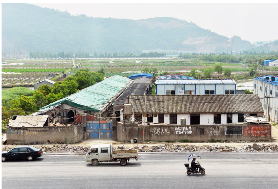
违法建筑的养猪场。记者 郑剑佩 摄
