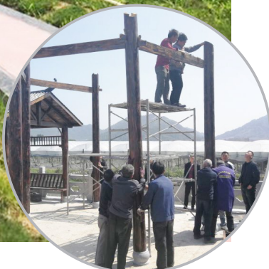
村民在搭长廊的亭子。 桥南村供图
